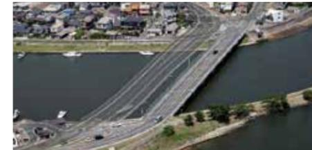
架橋後80年を経過し、老朽化が著しく耐震性能も低い。架け替えを行なっています。令和10年度の完成を予定しています。
